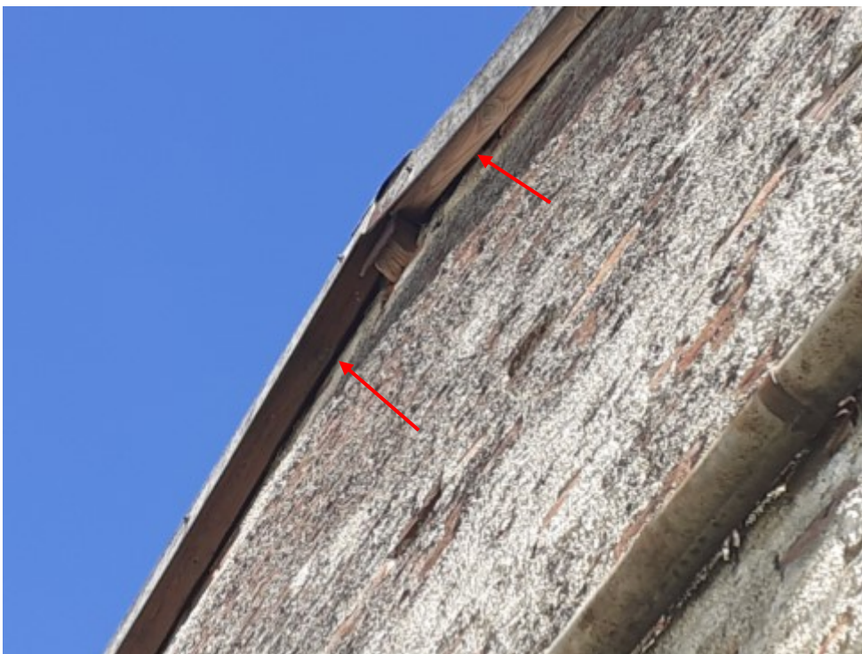
Abb. 2: Zwischen Balken und Mauer sind Fledermausquartiere nicht auszuschließen.
